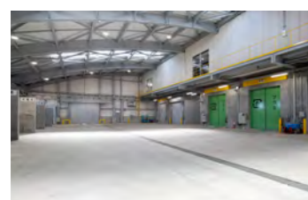
① プラットホーム 燃えないごみ、粗大ごみ、資源物を受け入れ、それぞれの受入貯留ヤードやピットに荷下ろしします。また、爆発や火災の原因となる危険物や選別の妨げとなる不適物を作業員の手で取り除きます。
